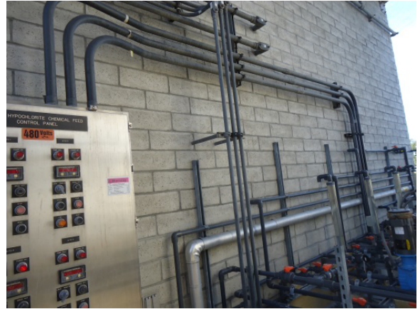
Chemical pump electrical conduits
