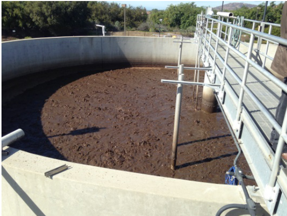
On-line aerobic digester
