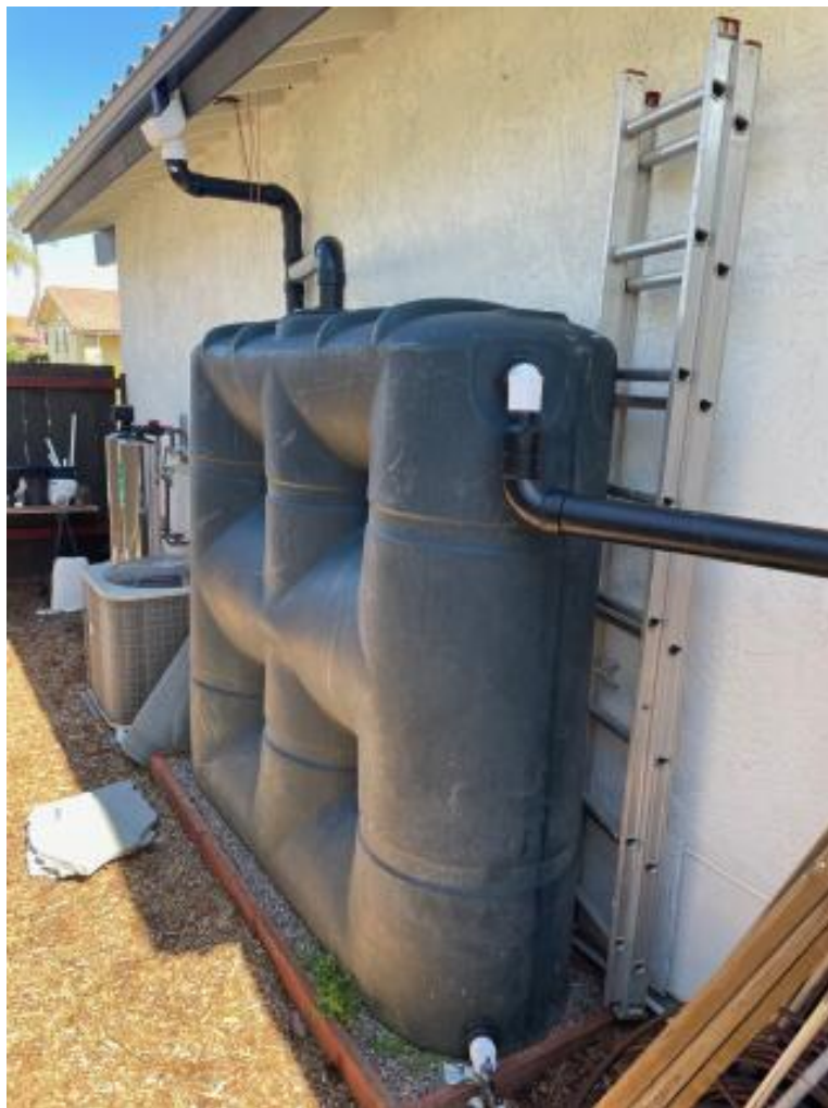
Lefkowits collects rainwater in a 530-gallon cistern.
